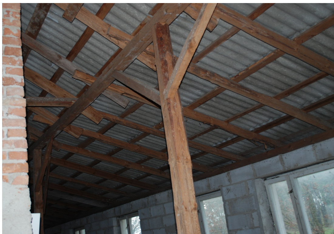
Fot. Istniejąca więźba dachowa – do rozbiórki
